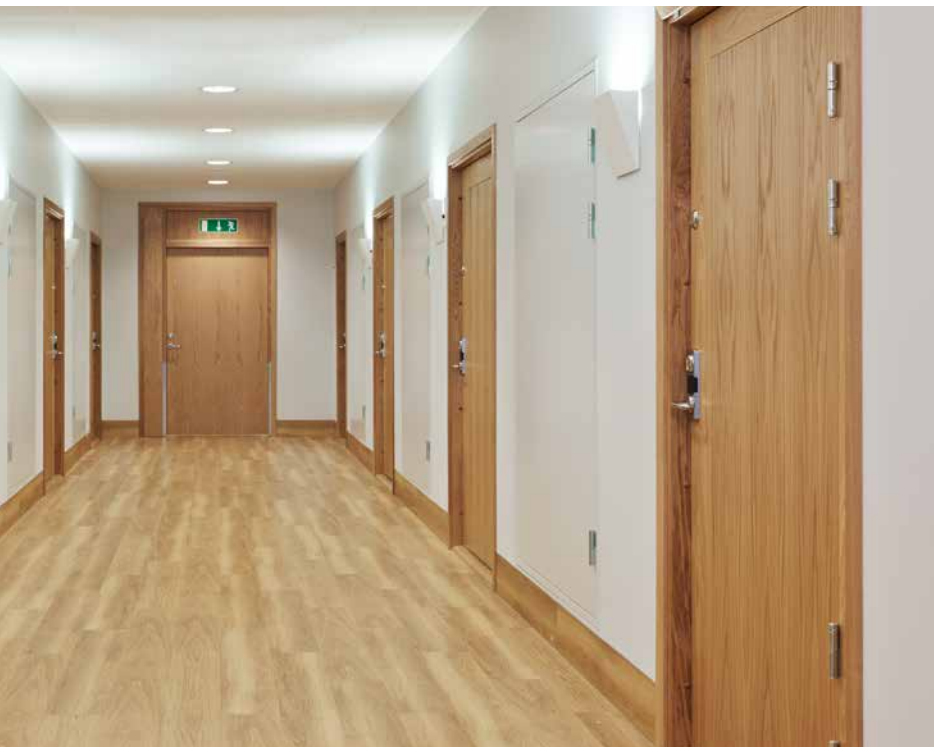
På det större dörrbladet finns fasade gångjärn i överkant, vilket minskar risken för patientskador. Övrig beslagning anpassas efter behov och kan styras elektroniskt eller manuellt.
