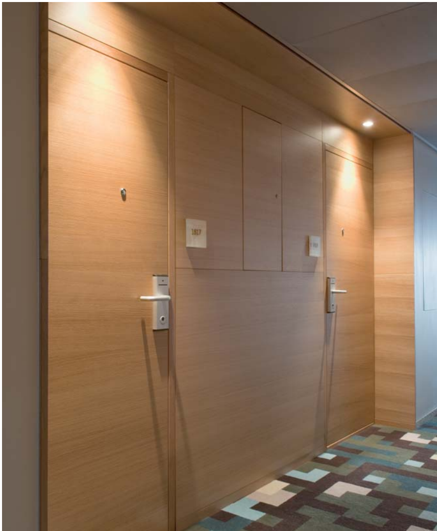
Rica Talk Hotel, Älvsjö: Liggande ekfaner på både panel och dörrar. Inåtgående dörrar med dolda gångjärn; utåtgående handikappdörrar med synliga gångjärn.
