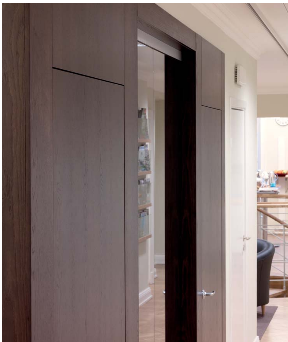
Kairos Future: Ultramoderna dörrar i betsad ek som kontrast till äldre detaljer från förra sekelskiftet. Inåtgående dörrar som en del i ett kraftigt väggparti. Inga synliga gångjärn och dold karm.
